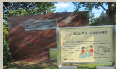
篠崎公園の震災対策用応急給水施設です。この付近の広域避難場所にも指定されています。
