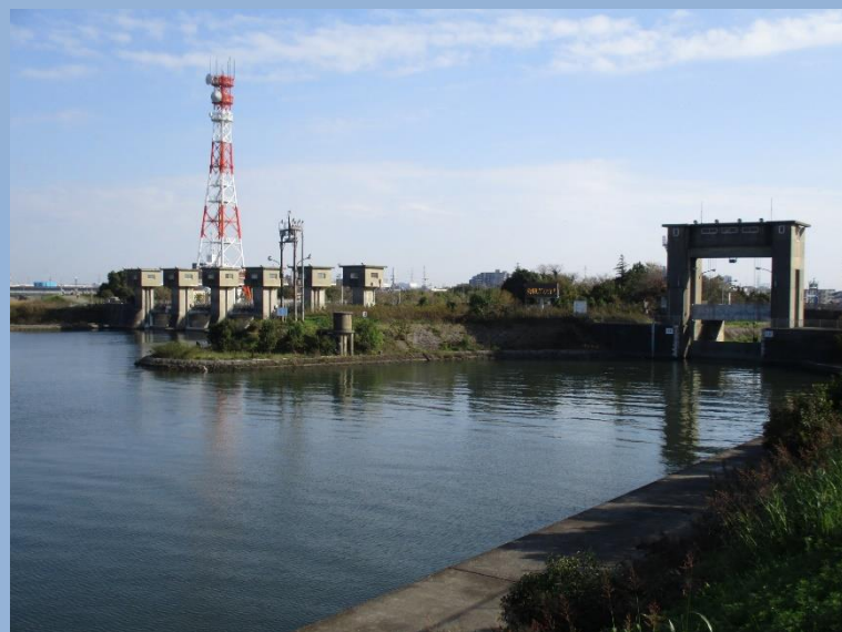
江戸川水閘門（右が閘門）
