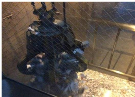
ごみを一時貯めておくバンカ。巨大クレーンでごみを混ぜ、焼却炉に投入します。
