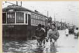
荒川下流、江戸川区の被災状況
