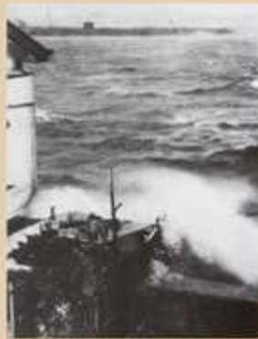
荒川下流、江戸川区の被災状況
