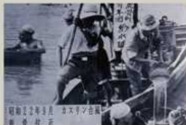
カスリーン台風（利根川決壊） 昭和 22 年 9 月（1947）
