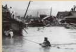
荒川下流、江戸川区の被災状況
