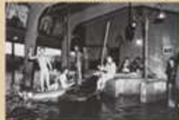
荒川下流、江戸川区の被災状況
