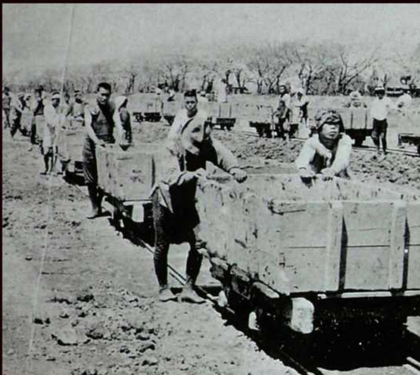
開削初期、人力掘削の様子
