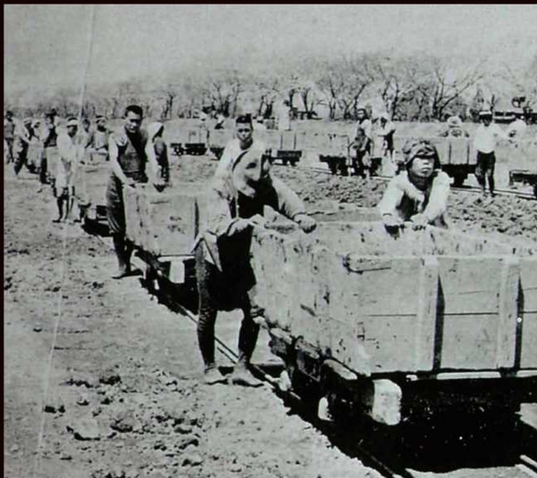
開削初期、人力掘削の様子
