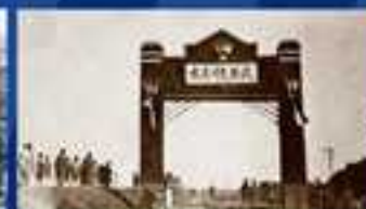
大正13年。各鉄道橋・岩淵水門・中川水門・木下川水門・隅田水門竣工。西新井村所在、旧桜土堤を切り開き低水路一部通水。
