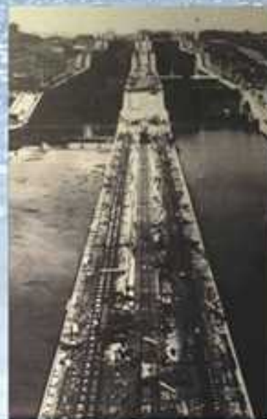
完成後のガッツン開門。中央のレールが敷かれている部分は青山氏の設計によるものです。
