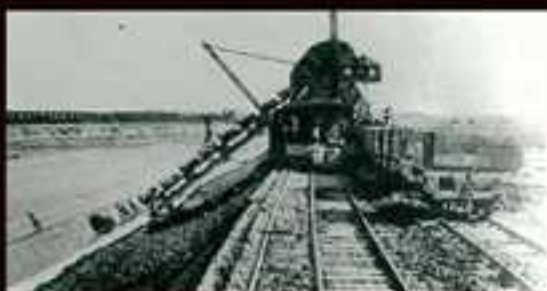
次に川岸に線路を敷き、その上に蒸気掘削機（エキスカ）を設置し、低水路を掘っていきました。
