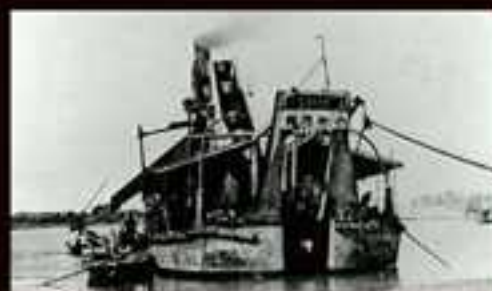
水路に水を通した後も、浚渫船で川底を深く掘っていきました。
